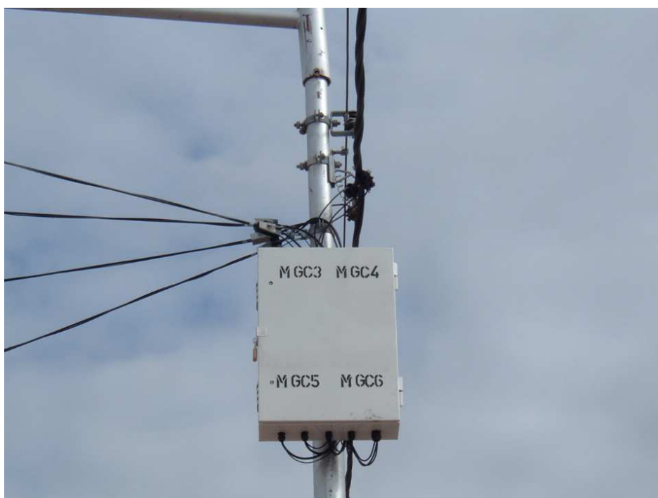
UBICACIÓN DE LAS CAJAS PERPENDICULARES A LA LÍNEA DE DISTRIBUCIÓN. DETALLE DE TENDIDO DE ACOMETIDAS. LAS FOTOGRAFÍAS SON SÒLAMENTE INDICATIVAS
