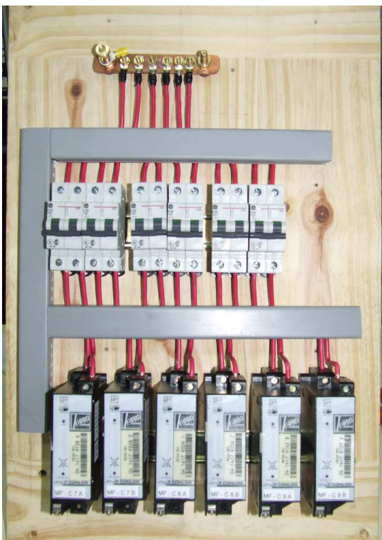
PROTECCIONES TERMOMAGNÉTICAS Y DISPENSADORES. CABLEADO, CONEXIONADO Y DISTRIBUCIÓN SOBRE LA MADERA DEL TABLERO. LAS FOTOGRAFÍAS SON SÓLAMENTE INDICATIVAS
